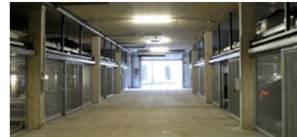
Sistema a tre livelli di parcheggio. Porte di sicurezza installate a livello entrata per evitare pericoli di caduta o schiacciamento durante lo spostamento delle piattaforme.
