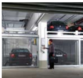
Stato iniziale del sistema di parcheggio. L'utente seleziona il proprio posto auto tramite una chiave codificata.
