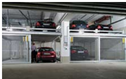
L'utente preleva l'auto dal posto di parcheggio e chiude la porta. Il sistema rimane in questa posizione fino alla prossima procedura di parcheggio.
