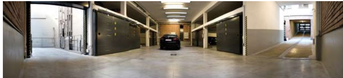
2 impianti installati ai lati della corsia di manovra per un totale di 25 posti auto meccanizzati sui quali è possibile parcheggiare auto con altezza fino a 2 m e con portata fino a 2.600 kg. Il consumo energetico è di soli 3 kW.
