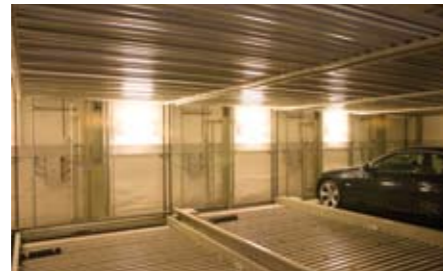
Piattaforme di parcheggio con pianale antiscivolo zincato a caldo.
