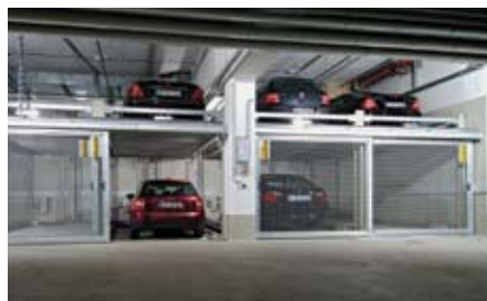
Una volta raggiunta la posizione finale la piattaforma si blocca meccanicamente mentre la porta manuale si sblocca per l'apertura (le porte possono essere anche automatiche con apertura tramite telecomando).
