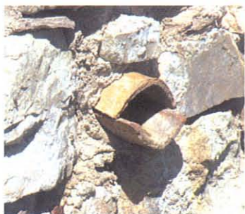
1-3. Per la struttura della limonaia si sono ripristinati ed in alcuni casi reintegrati, alcuni sistemi caratteristici come i doccioni nelle murature ad archi realizzati in coppi capovolti piuttosto che il convogliamento su canaline in pietra funzionali all'irrigazione.
