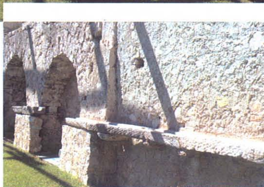
1-3. Per la struttura della limonaia si sono ripristinati ed in alcuni casi reintegrati, alcuni sistemi caratteristici come i doccioni nelle murature ad archi realizzati in coppi capovolti piuttosto che il convogliamento su canaline in pietra funzionali all'irrigazione.
